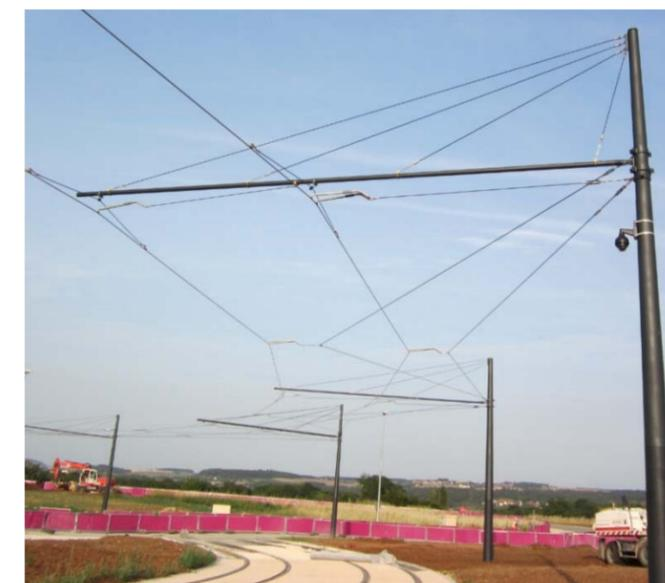
Figure 21 : Exemple poteau latéral avec consoles couvrant les 2 voies tramway (Tramway de Dijon)
