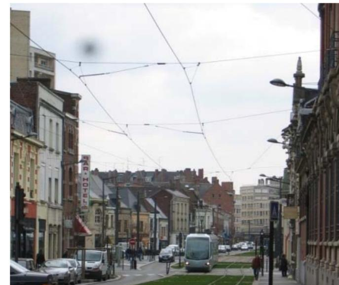
Figure 20 : Exemple ancrages en façade latéraux avec suspension sous transversal (Tramway de Valenciennes)
