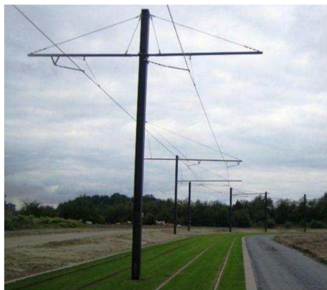
Figure 22 : Exemple poteau axial avec 2 consoles couvrant chacune 1 voie tramway (Tramway de Valenciennes)
