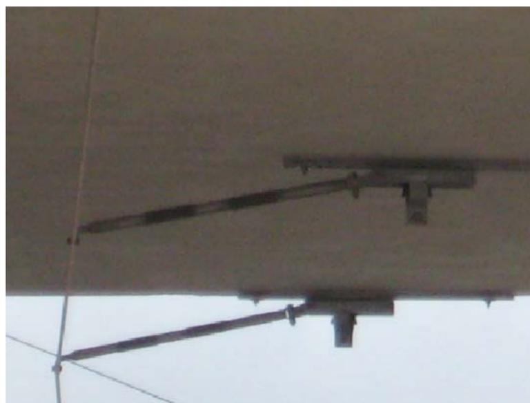
Figure 23 : Exemple d'accrochage sous ouvrage avec bras de rappel compensé (Tramway d'Orléans)
